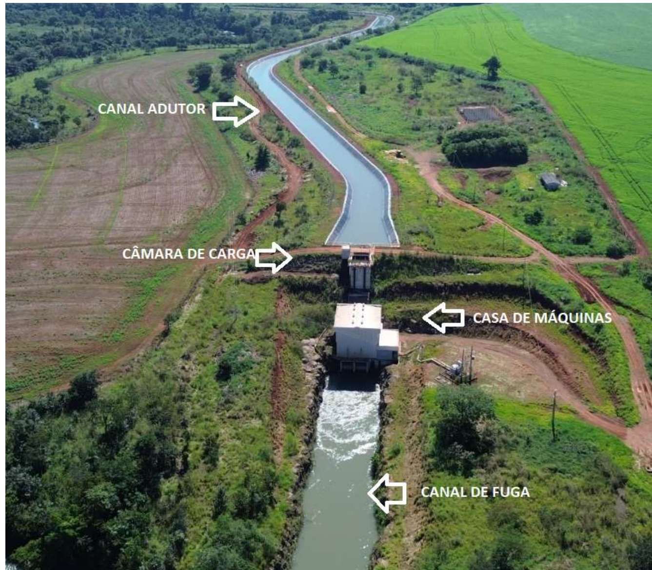
Figura 9 – Casa de máquinas da CGH Córrego Ger
