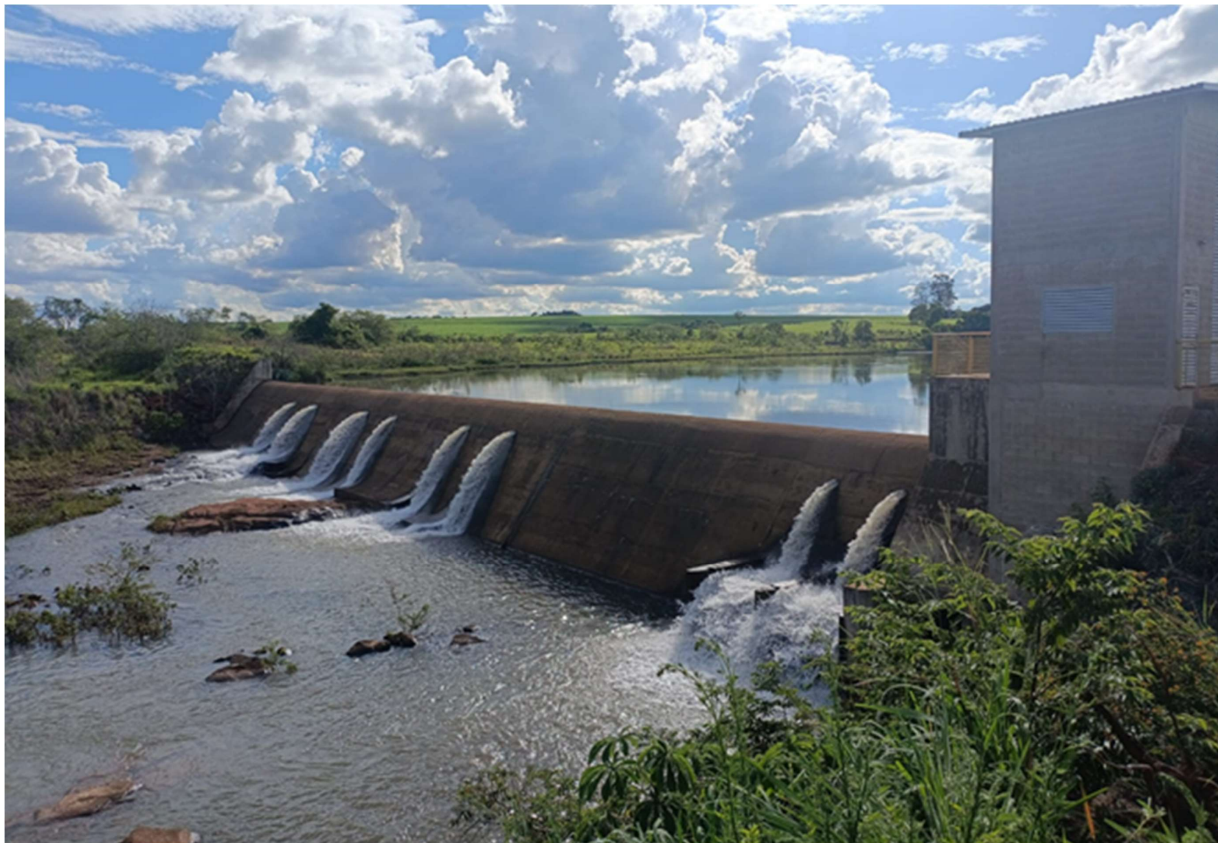
Figura 8 – Estruturas do Barramento/Vertedouro da CGH Córrego Ger
