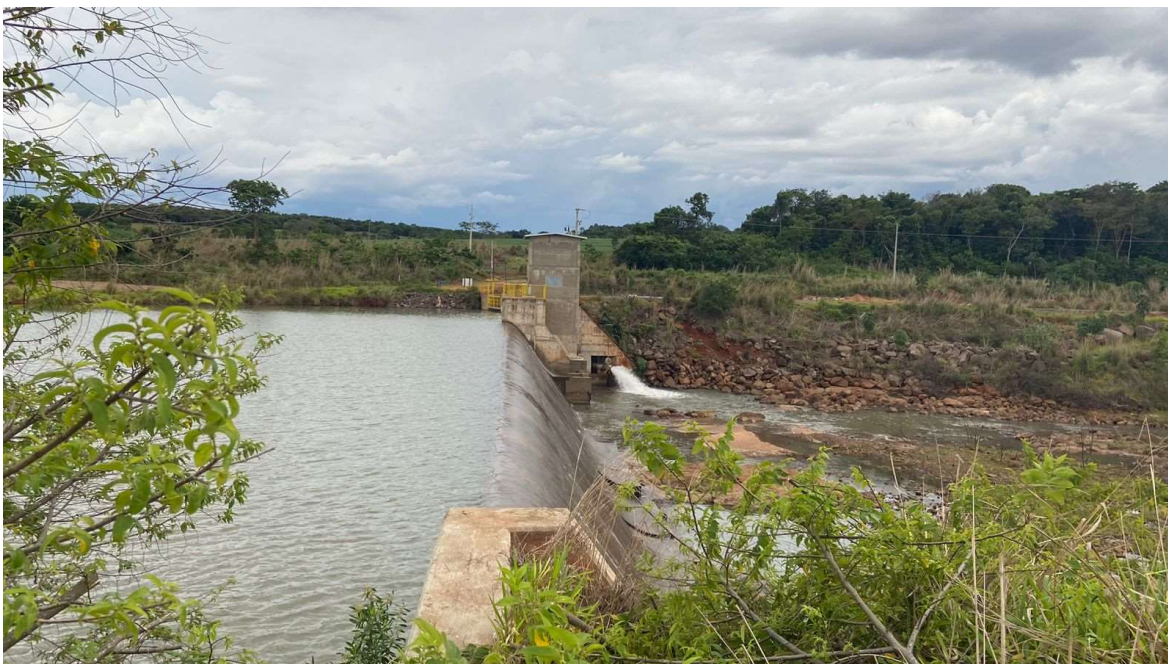
Figura 17 – Visão a partir da margem direita, foco eixo da barragem e margem esquerda com detalhe topo do muro da ombreira direita
