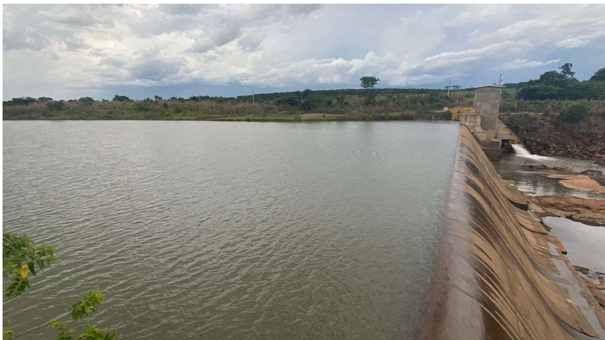
Figura 10 – Visão a partir da margem direita, foco eixo da barragem e margem esquerda
