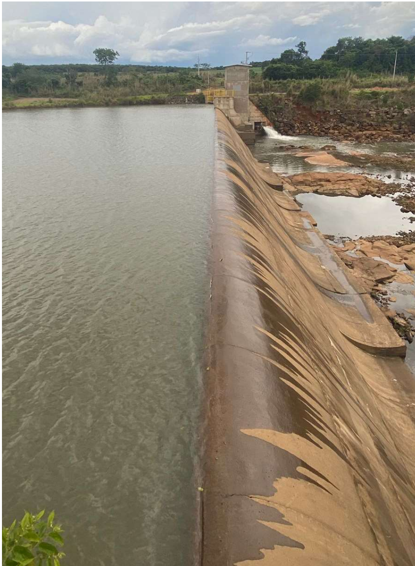
Figura 11 – Visão a partir da margem direita, foco eixo da barragem
