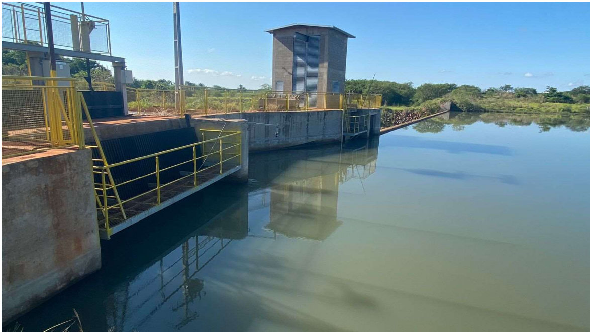
Figura 31 – Visão a partir da margem esquerda, foco eixo da barragem, montante da barragem e entrada da tomada d'água
