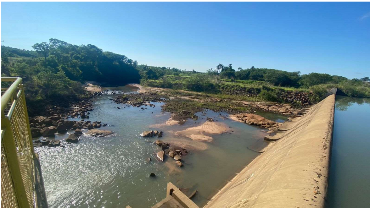
Figura 30 – Visão a partir da margem esquerda, foco eixo da barragem, jusante da barragem e margem direita
