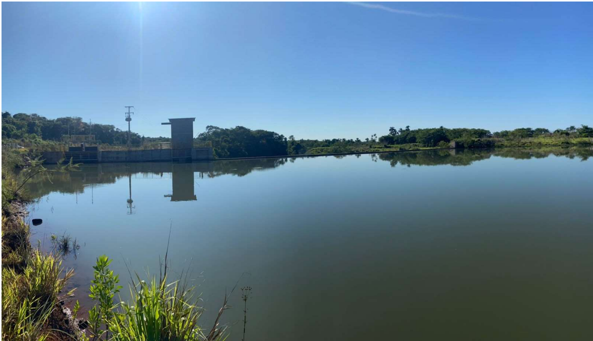
Figura 23 – Visão a partir da margem esquerda, foco eixo da barragem e estruturas
