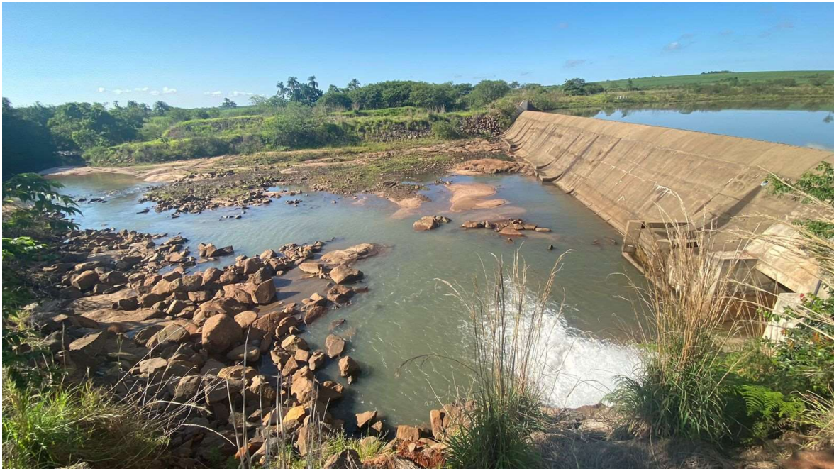
Figura 29 – Visão a partir da margem esquerda, foco eixo da barragem, jusante da barragem e margem direita
