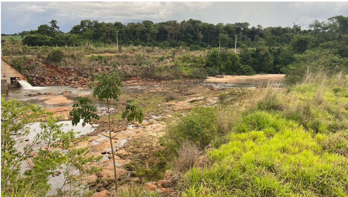
Figura 16 – Visão a partir da margem direita, foco a jusante da barragem dissipador em rocha aflorante
