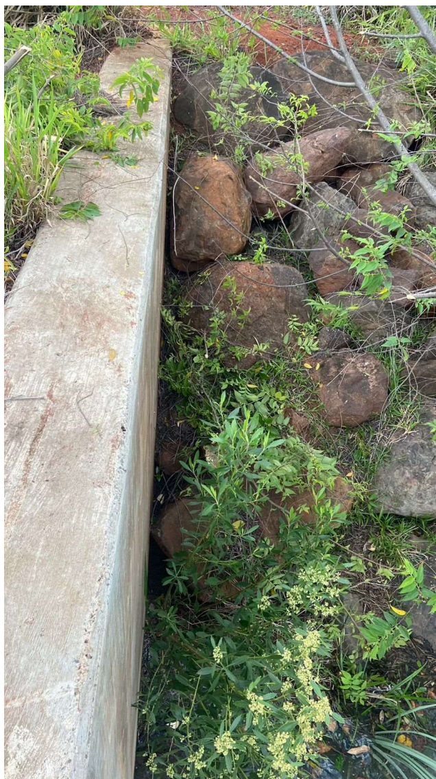
Figura 12 – Visão a partir da margem direita, muro da ombreira direita envolvida a montante por aterro em solo e enrocamento de pedra
