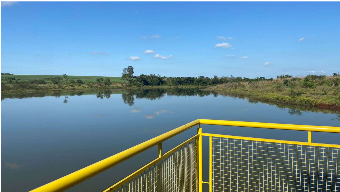
Figura 24 – Visão a partir da margem esquerda, foco reservatório de margem direita e esquerda
