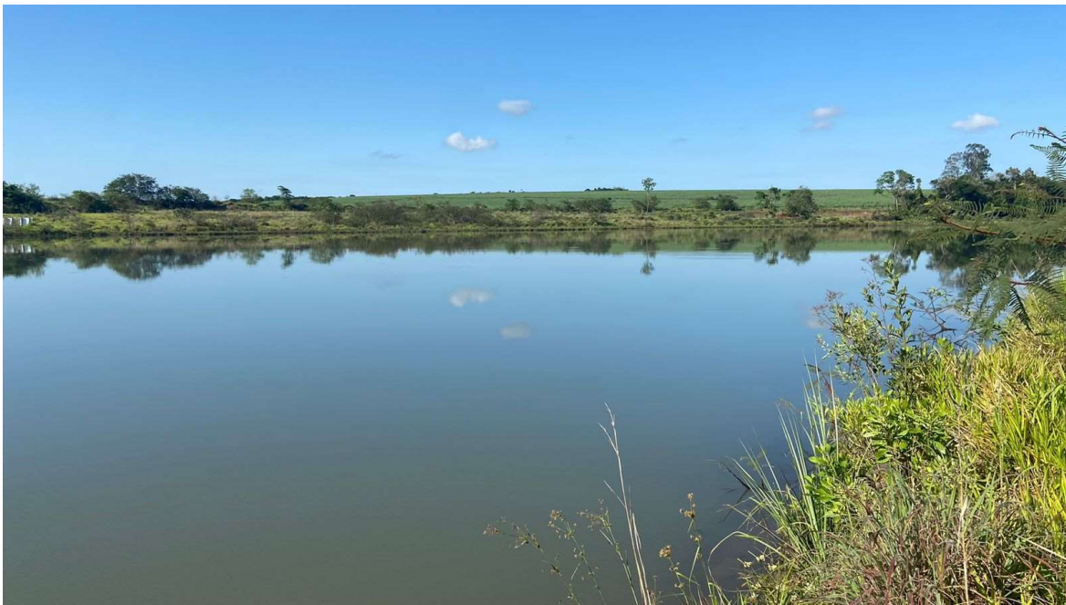
Figura 20 – Visão a partir da margem esquerda, foco margem direita do reservatório
