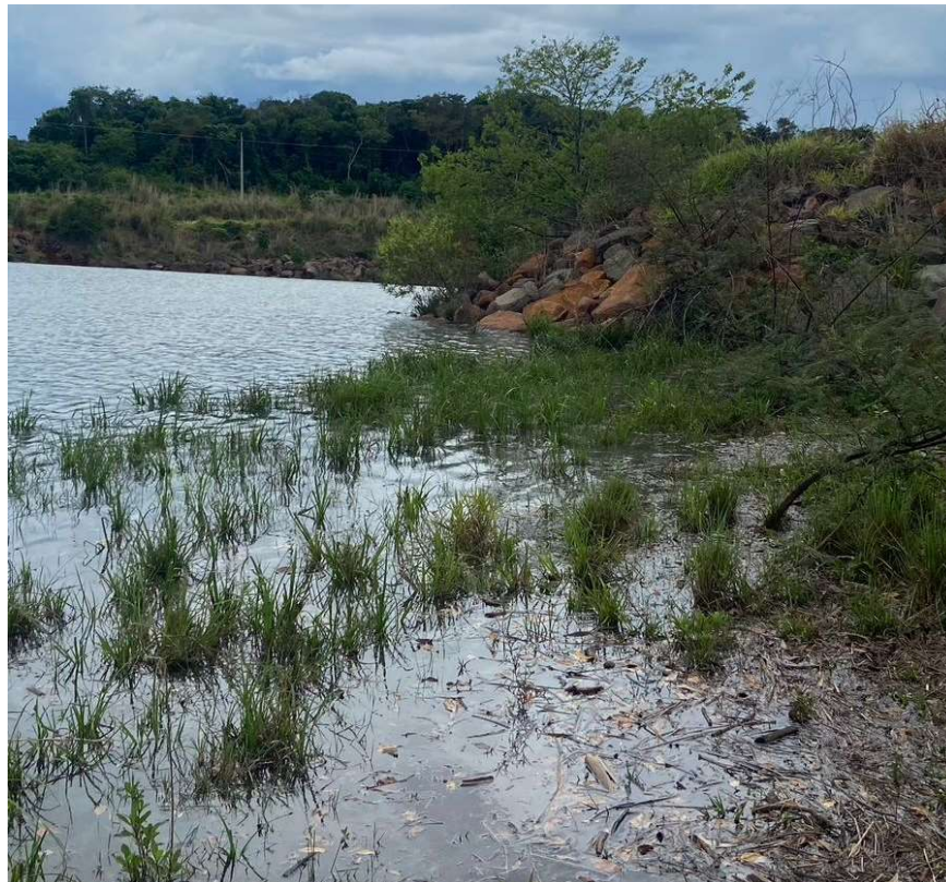
Figura 04 – Visão a partir da margem direita, foco em direção a ombreira direita da barragem (enrocamento)
