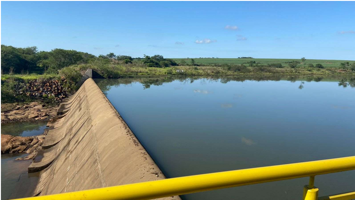
Figura 25 – Visão a partir da margem esquerda, foco eixo da barragem e margem direita
