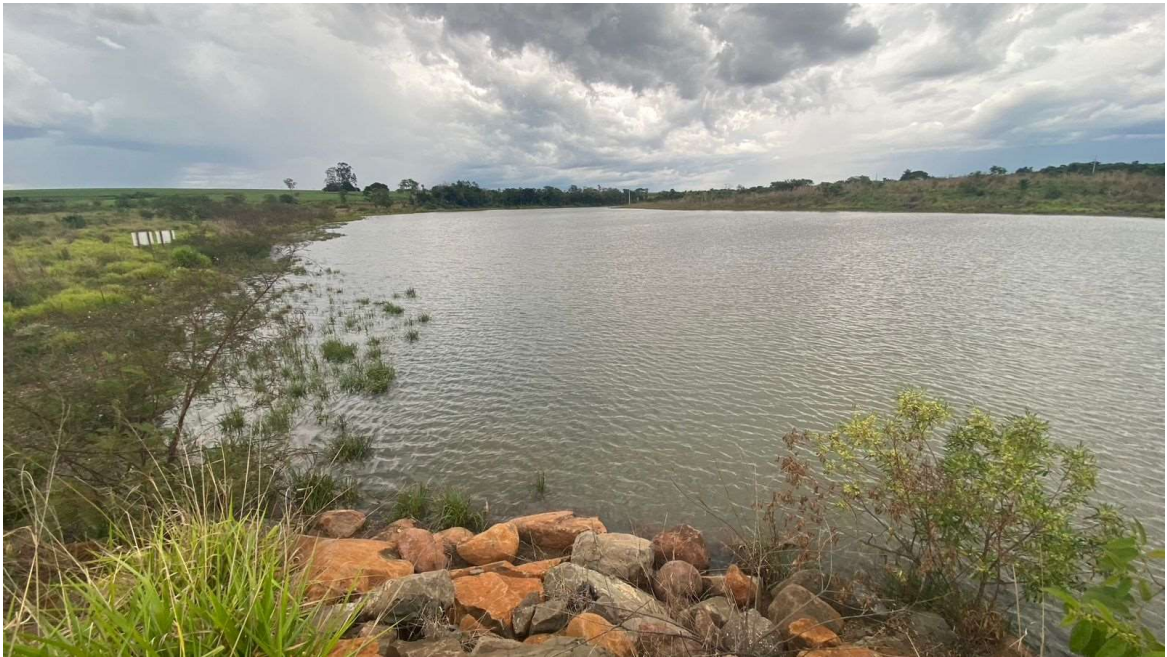
Figura 14 – Visão a partir da margem direita, visão do enrocamento de pedra a montante da ombreira
