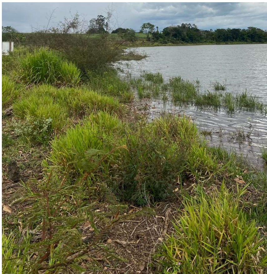
Figura 06 – Visão a partir da margem direita, foco em direção a margem direita do reservatório
