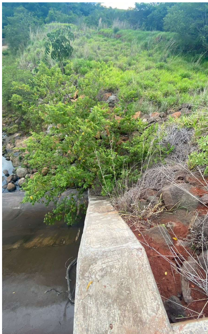
Figura 13 – Visão a partir da margem direita, muro da ombreira direita envolvida a jusante por aterro em solo e enrocamento de pedra
