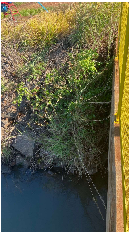
Figura 22 – Visão a partir da margem esquerda, foco ombreira da margem esquerda
