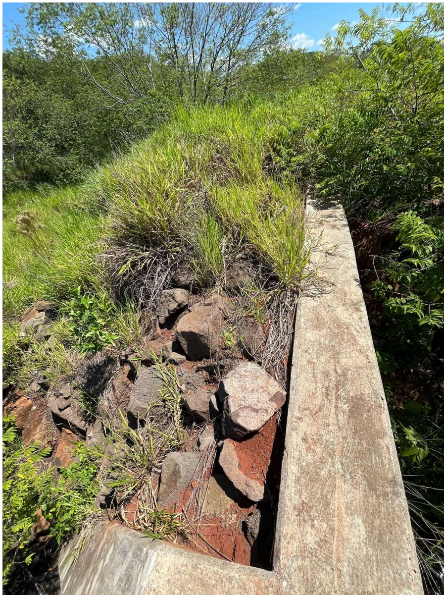
Figura 25 – Detalhe enrocamento e proteção vegetal da ombreira direita
