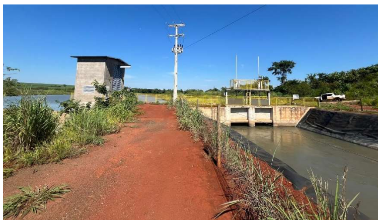
Figura 08 – Anomalia corrigida com recomposição e compactação de solo (RISR2024)
