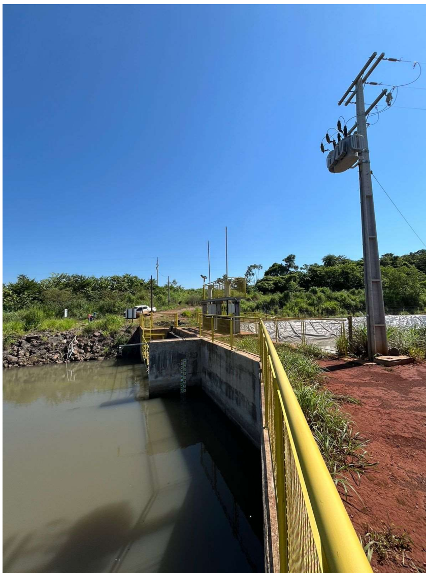
Figura 27 – Detalhe ombreira esquerda/tomada d'água
