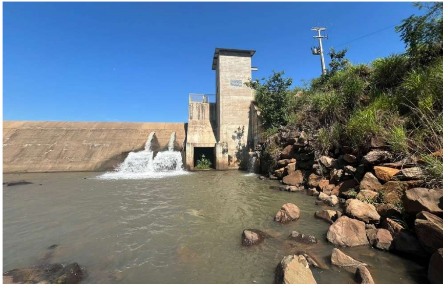
Figura 23 – Visão a partir da margem esquerda, foco descarga de fundo, jusante da barragem e enrocamento margem esquerda
