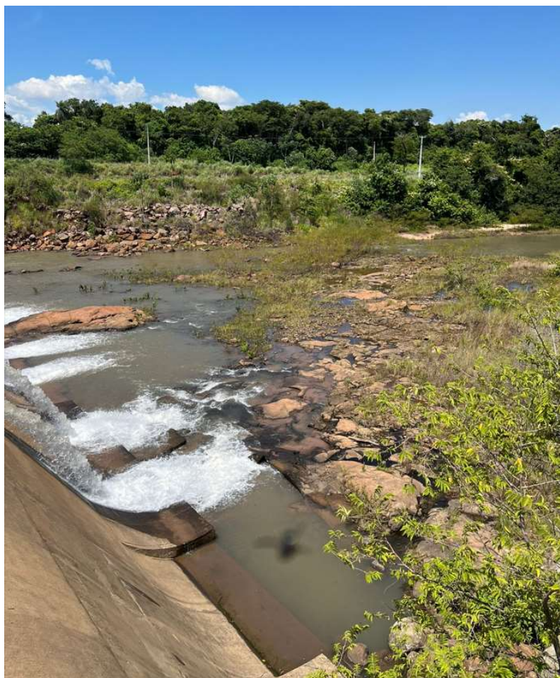
Figura 15 – Visão a partir da margem direita, foco a jusante da barragem dissipador em rocha aflorante / margens protegidas com enrocamento de pedra
