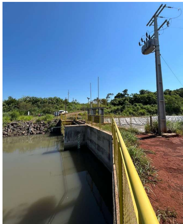
Figura 20 – Visão a partir da margem esquerda, foco ombreira esquerda da barragem e estruturas
