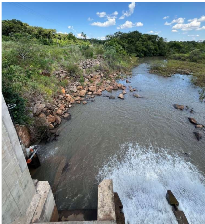
Figura 07 – Anomalia corrigida com enrocamento de pedras e vegetação (RISR2024)
