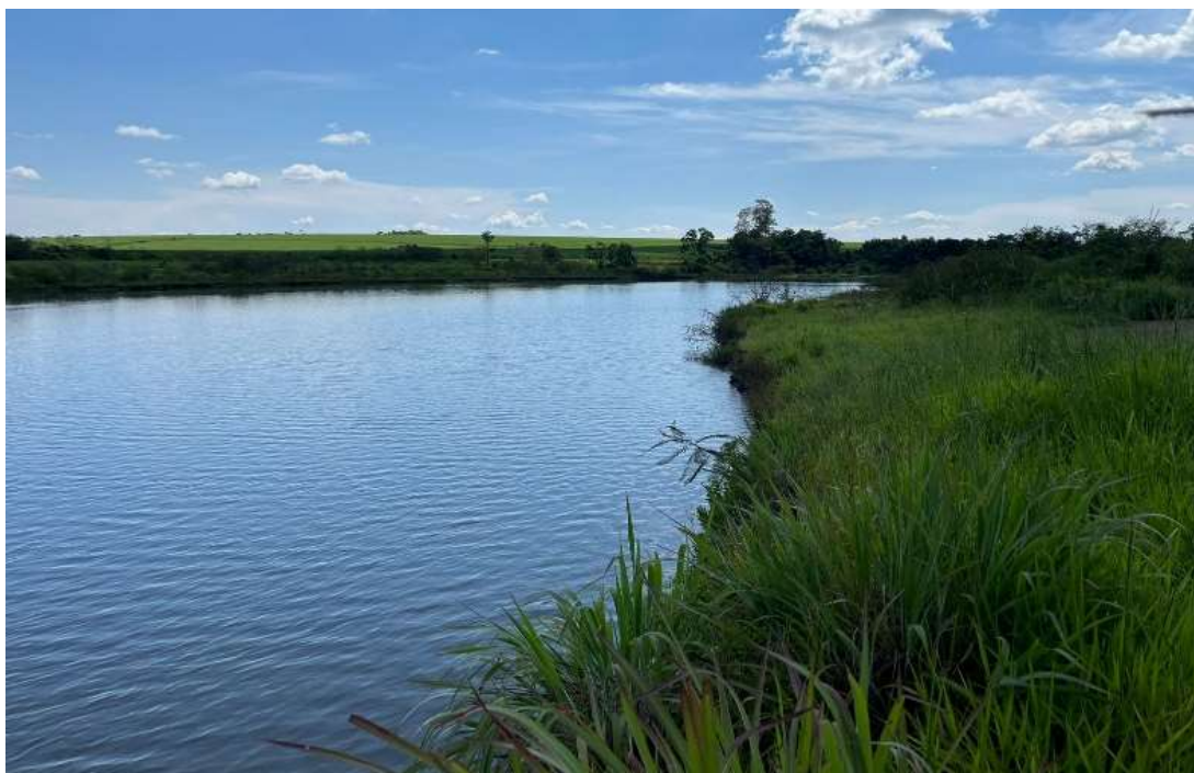
Figura 12 – Visão a partir da margem esquerda, foco em direção ao reservatório
