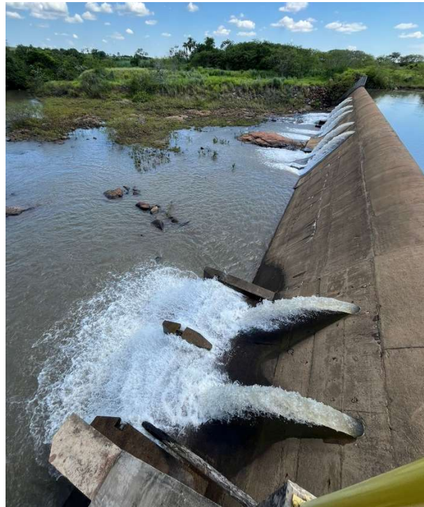
Figura 19 – Visão a partir da margem esquerda, foco eixo da barragem e margem direita
