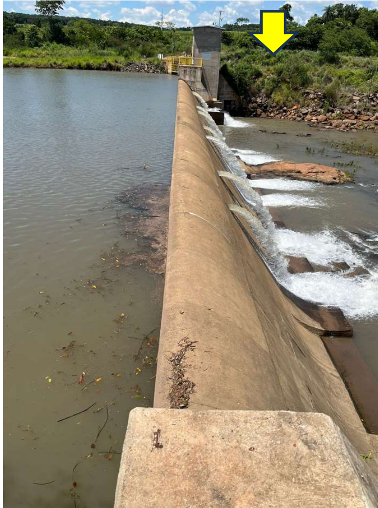
Figura 04 – Anomalia corrigida com enrocamento de pedras e vegetação (RISR2024)
