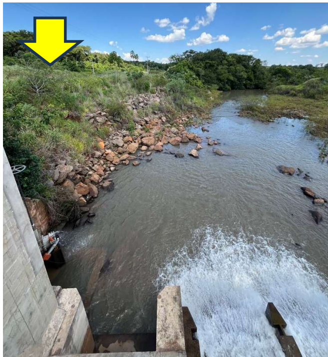
Figura 05 – Anomalia corrigida com enrocamento de pedras e vegetação (RISR2024)
