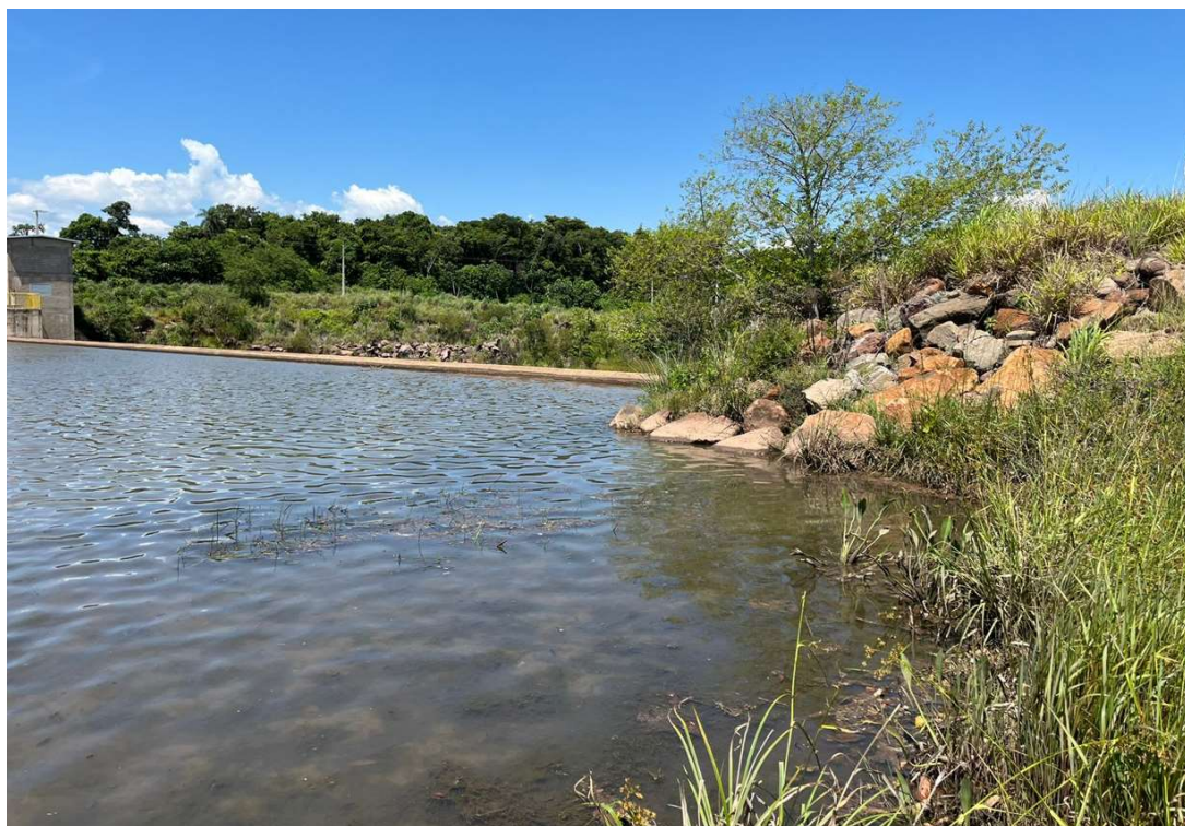
Figura 13 – Visão a partir da margem direita, foco em direção a ombreira direita da barragem (bem protegida com enrocamento)
