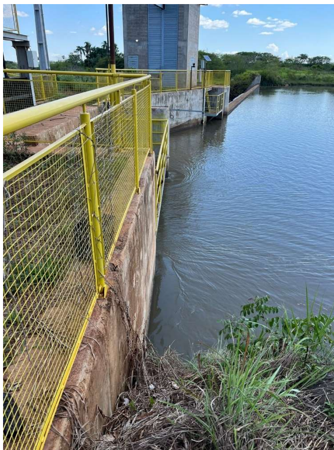
Figura 26 – Detalhe ombreira esquerda
