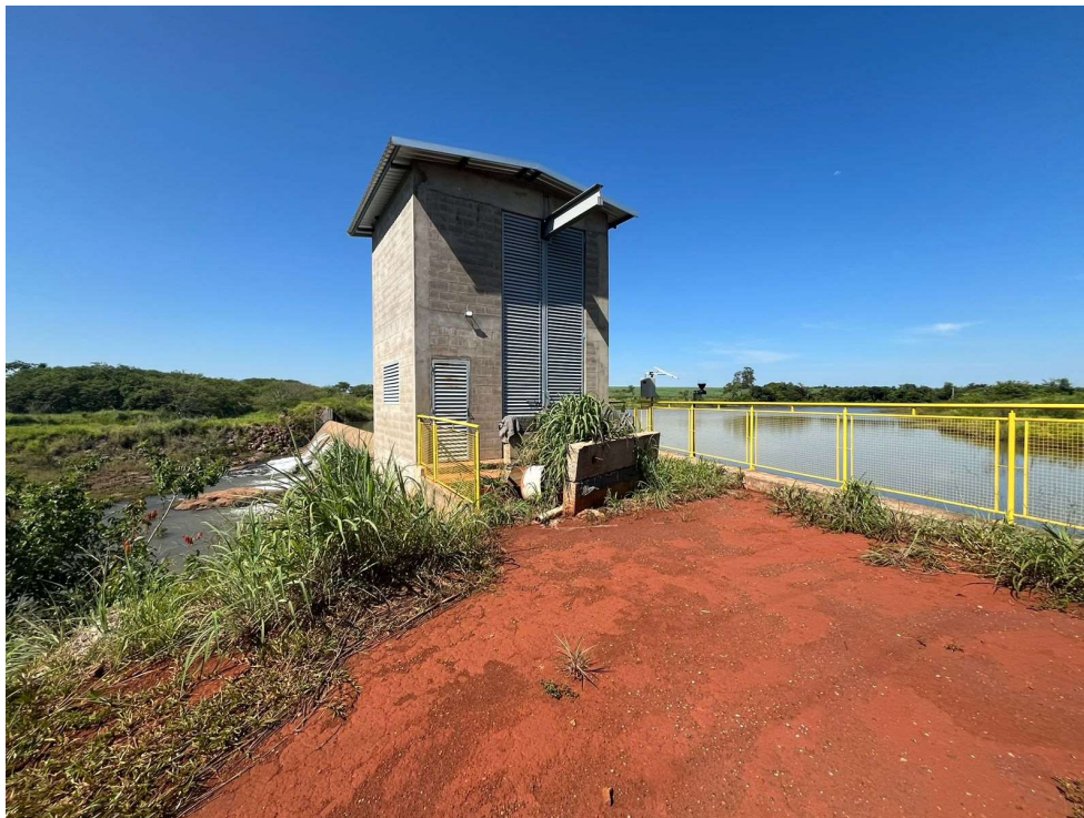
Figura 09 – Anomalia corrigida com recomposição e compactação de solo (RISR2024)
