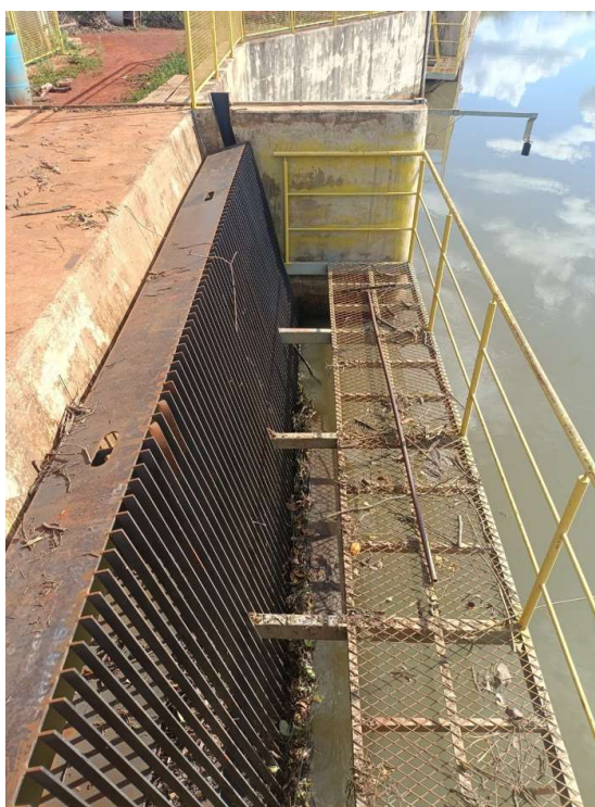
Figura 38 – Visão a partir da ombreira esquerda, foco grade tomada d'água
