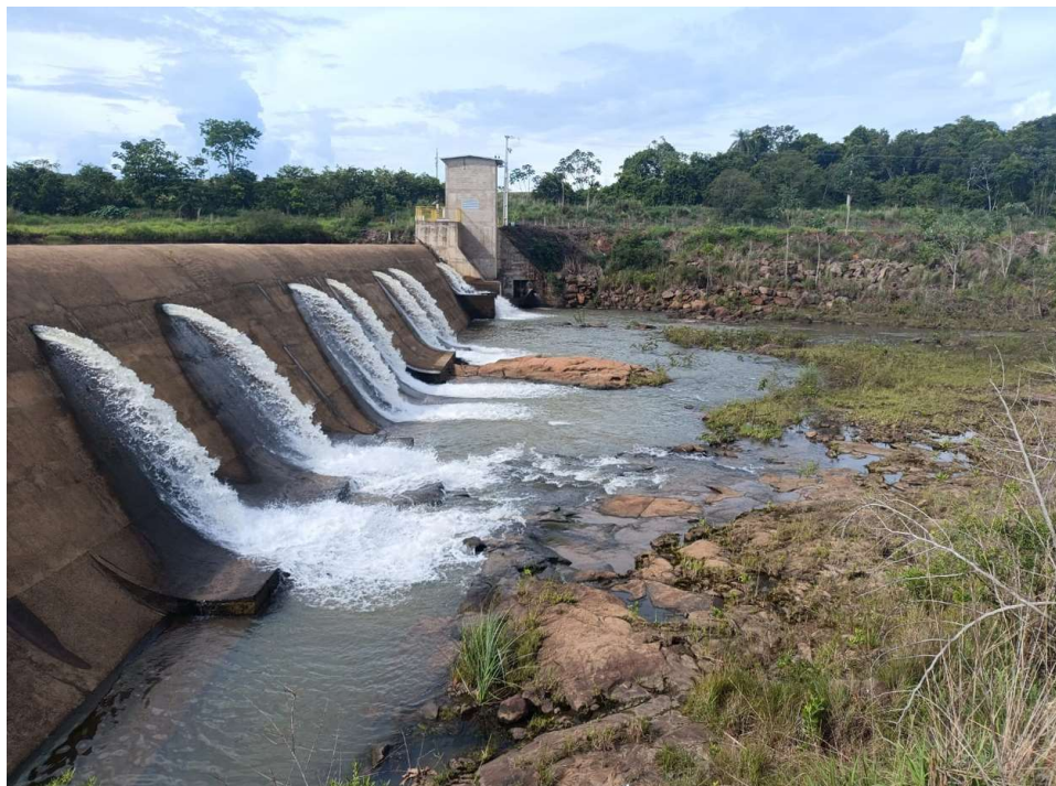
Figura 20 – Visão a partir da ombreira direita, foco eixo da barragem e margem esquerda
