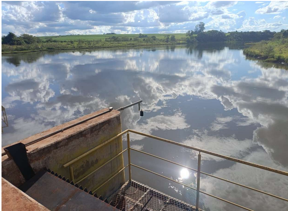
Figura 31 – Visão a partir da tomada d'água, foco reservatório
