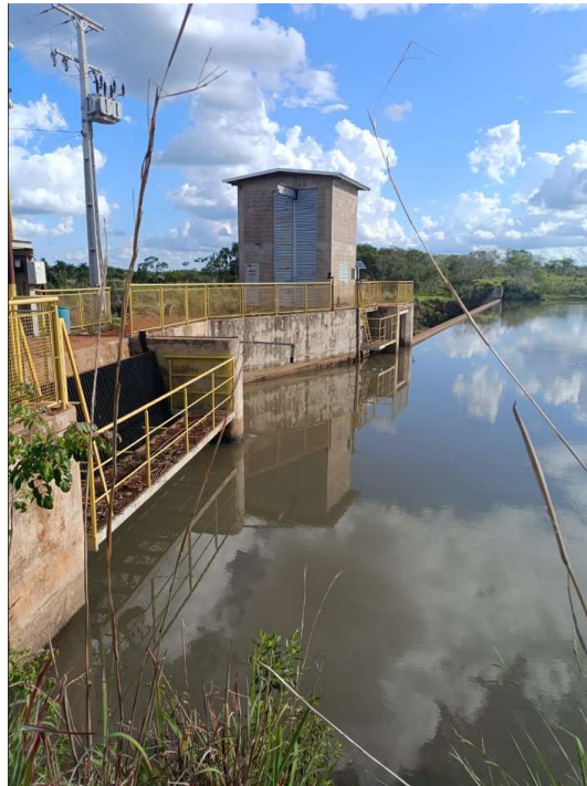
Figura 23 – Visão a partir da ombreira esquerda, foco eixo da barragem
