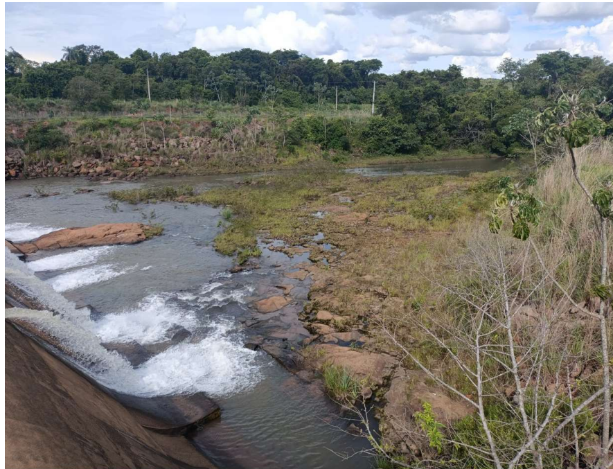
Figura 19 – Visão a partir da ombreira direita, foco a jusante da barragem dissipador em rocha aflorante
