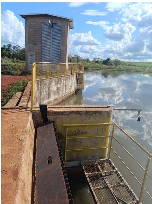
Figura 37 – Visão a partir da ombreira esquerda/tomada d'água, foco eixo da barragem
