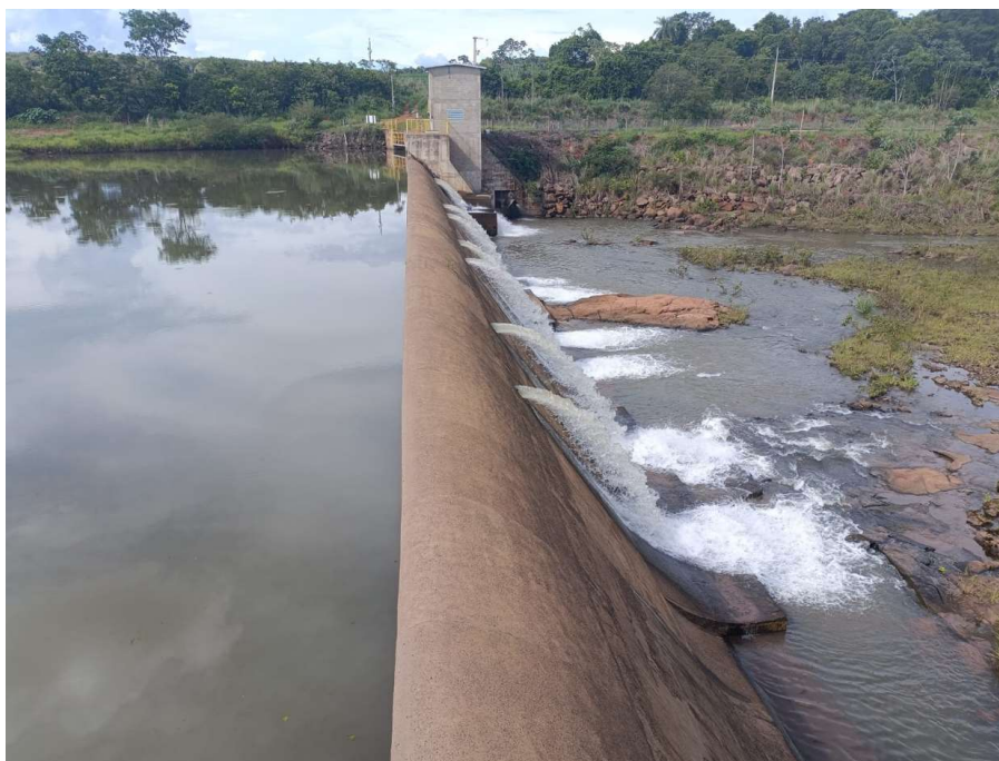
Figura 17 – Visão a partir da ombreira direita, foco eixo barragem
