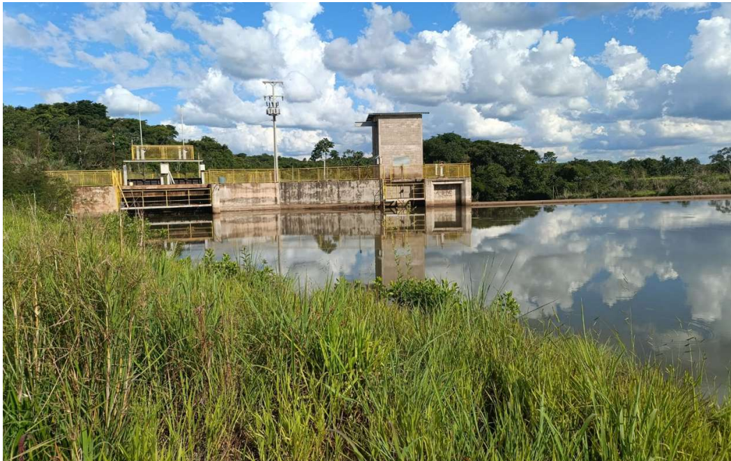
Figura 29 – Visão a partir da margem esquerda, foco eixo da barragem e estruturas
