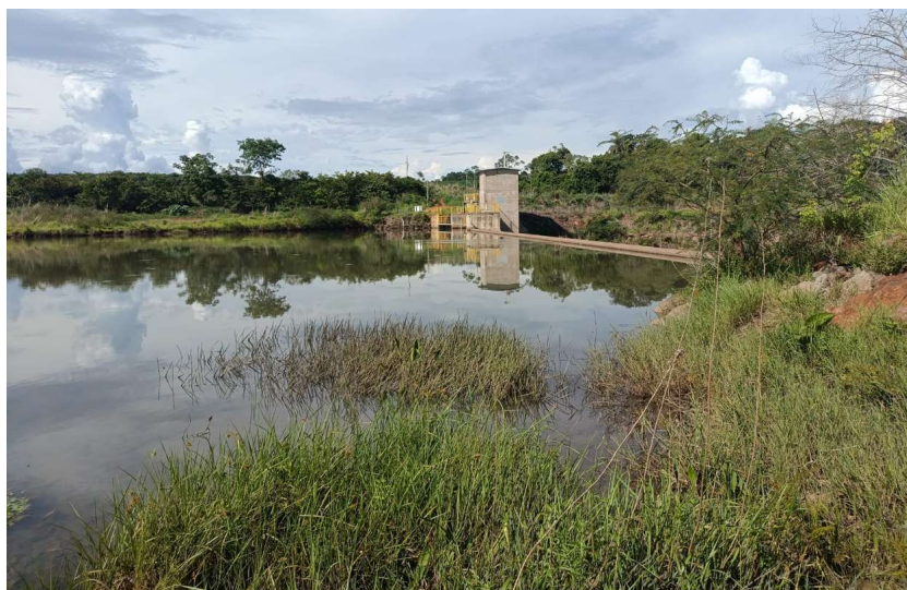
Figura 16 – Visão a partir da margem direita, foco em direção a ombreira esquerda da barragem
