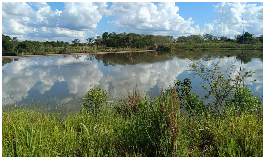
Figura 30 – Visão a partir da margem esquerda, foco eixo da barragem
