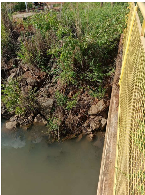
Figura 34 – Visão a partir da tomada d'água, foco ombreira esquerda
