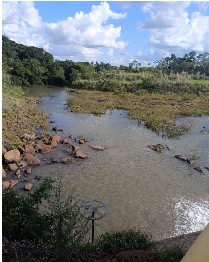
Figura 35 – Visão a partir da mini central, foco jusante da barragem
