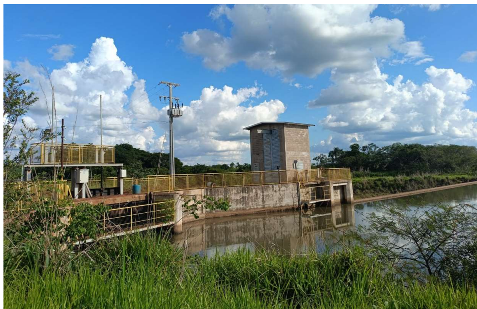
Figura 33 – Visão a partir da margem esquerda, foco barragem
