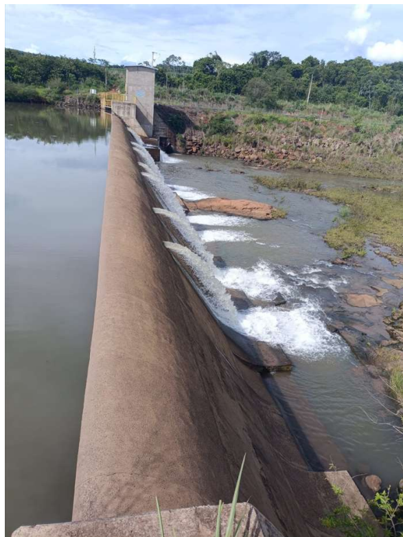
Figura 22 – Visão a partir da ombreira direita, foco eixo da barragem e margem esquerda
