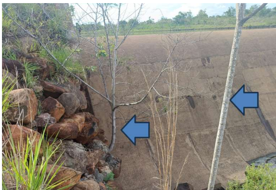
Figura 5 – Podar arbustos junto a ombreira direita a jusante
