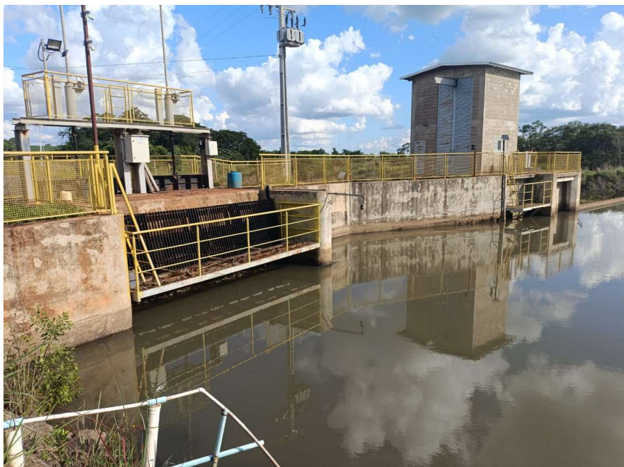
Figura 28 – Visão a partir da margem esquerda, foco eixo da barragem e estruturas
