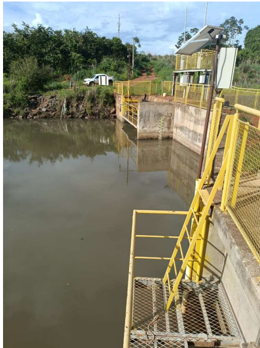
Figura 27 – Visão a partir da mini central, foco ombreira esquerda da barragem e estruturas
