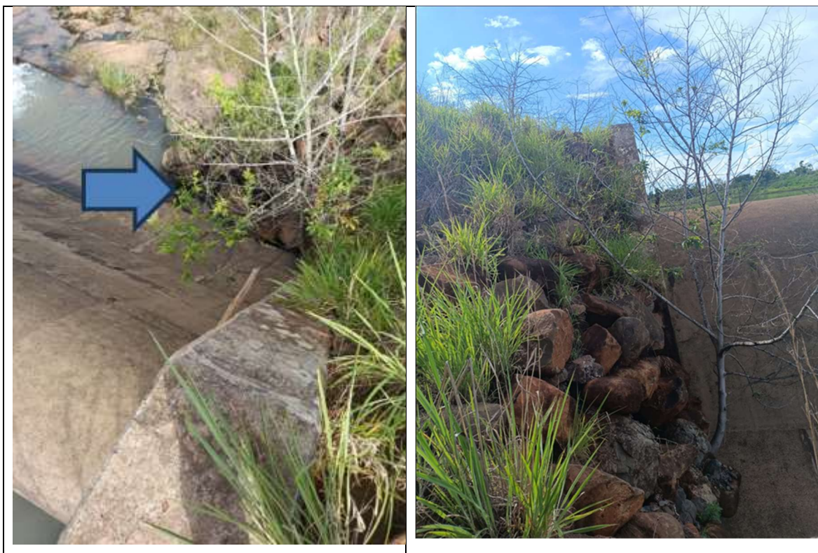
Figura 6 – Podar arbustos junto a ombreira direita a jusante
