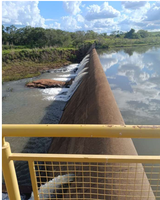
Figura 25 – Visão a partir da mini central, foco eixo da barragem e margem direita
