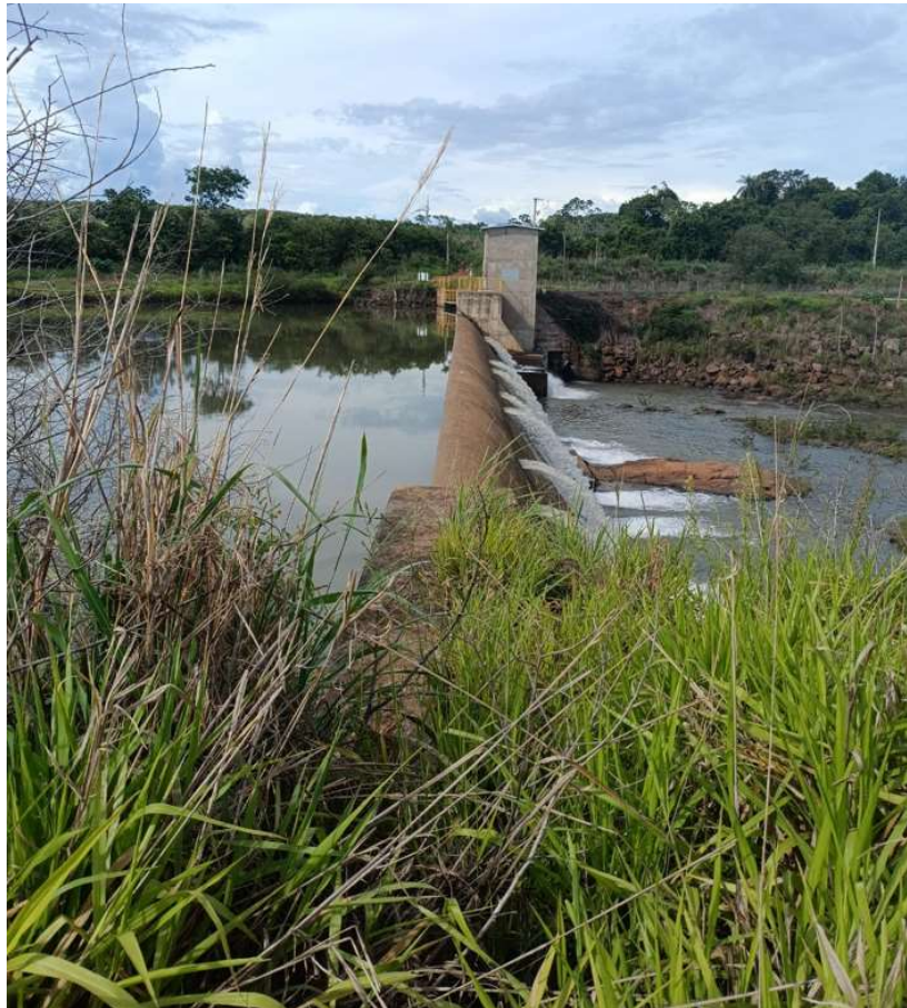
Figura 15 – Visão a partir da ombreira direita, foco eixo barragem
