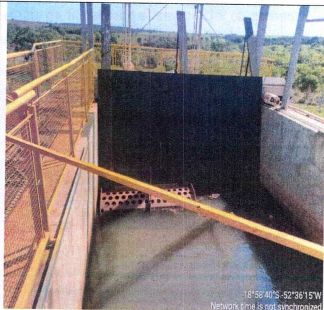
**Figura 04:** Estrutura metálica sem saída dos animais, chamado de "Limpa Grade", onde a capivara estava em repouso e onde os animais morrem e são retirados lançados pela esteira para fora da água no solo onde se acumulam as carcaças.
