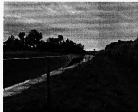
Figuras 06 e 07: Mostram as bordas do canal revestidas por lona e as cercas de proteção em tela com fixação inadequada para impedimento de passagem de animais. (Fonte: Relatório de Fiscalização Ambiental n° 34/2022/2° GPMA/Costa Rica- MS).
