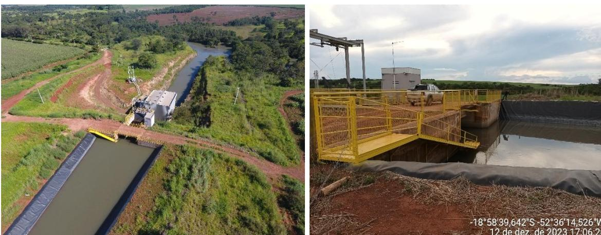
**Figura 29.** Passarela construída emergencialmente para resgate de fauna que eventualmente entre no canal.
