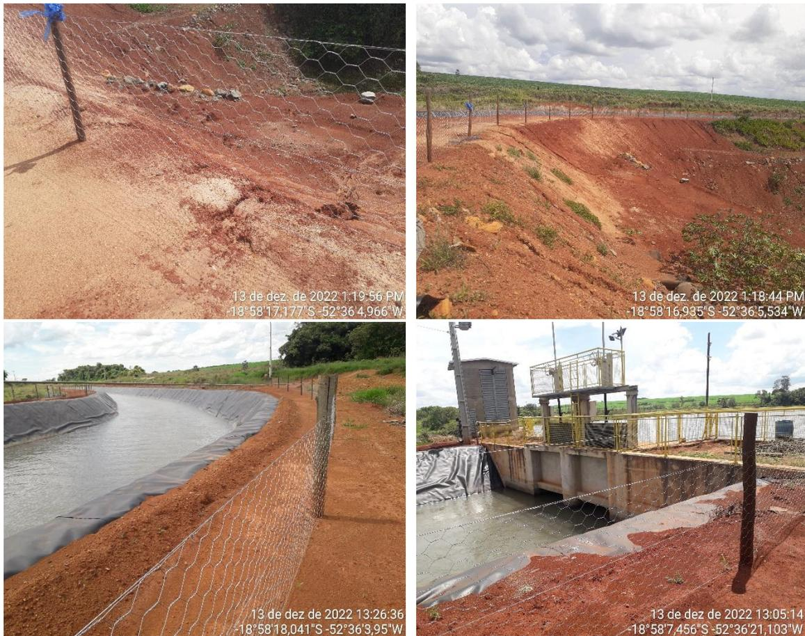
**Figura 28.** Trechos do canal de derivação apresentando novas telas de proteção.
